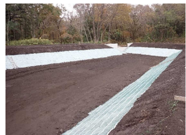
仮設防災調整池の設置例
