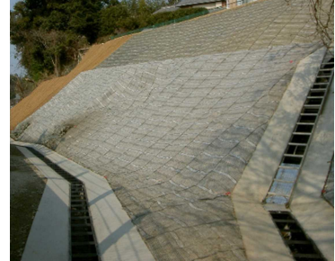
法面保護工の施工例
