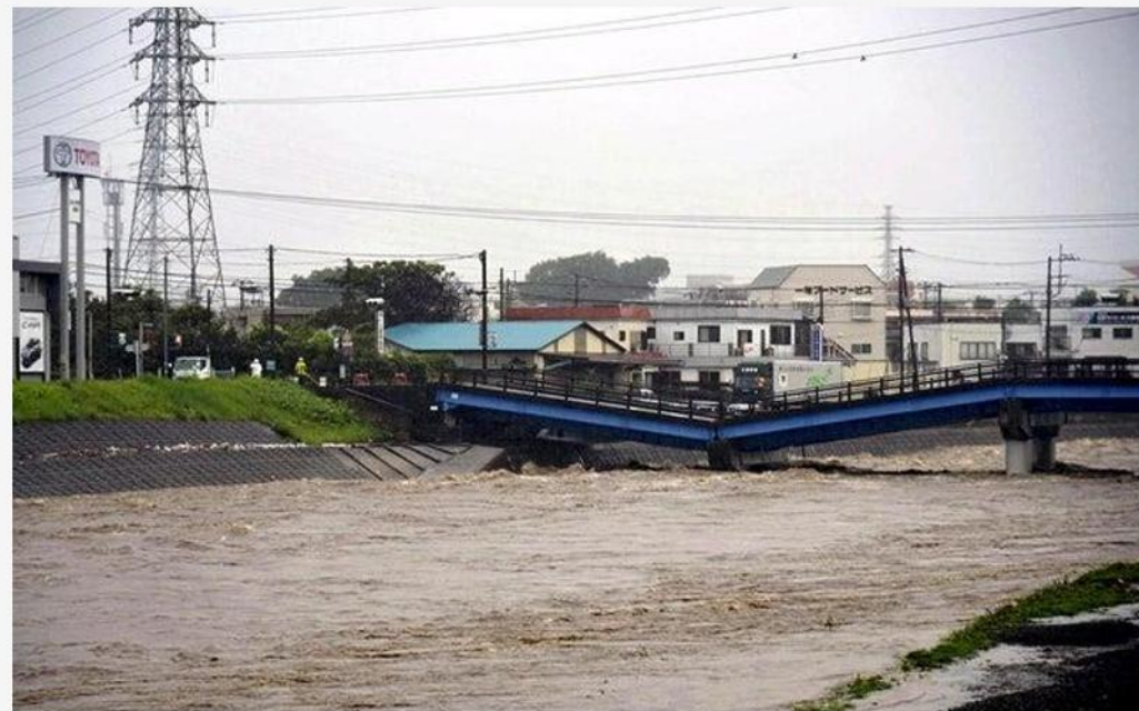
図1 2021年豪雨によって折れた黄瀬大橋(沼津市内)
