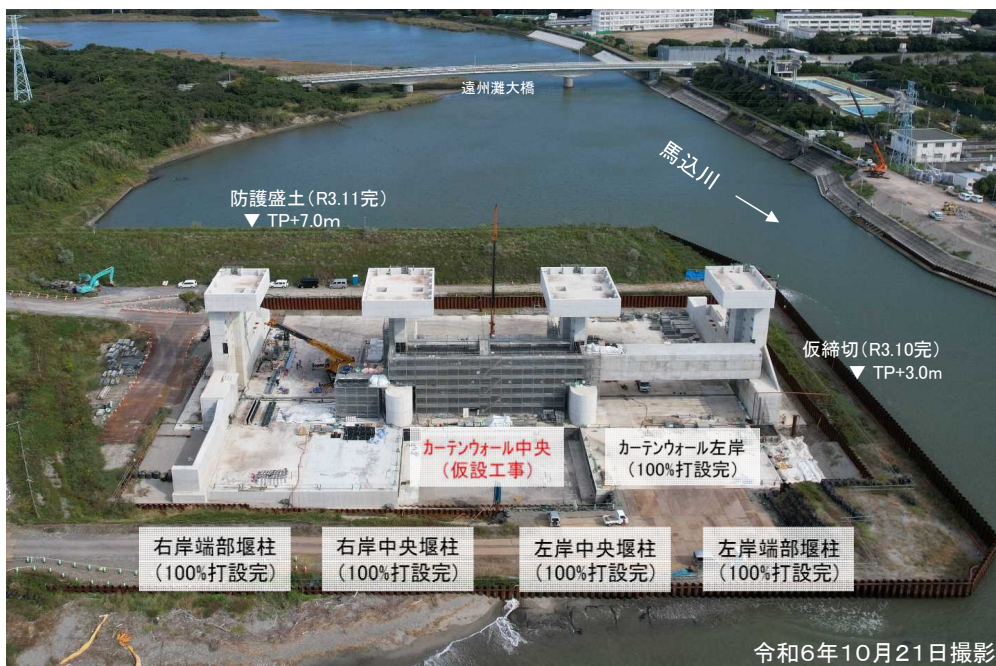
馬込川水門 整備状況 (令和6年10月現在)
