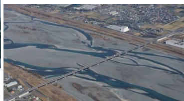
長大橋の整備
