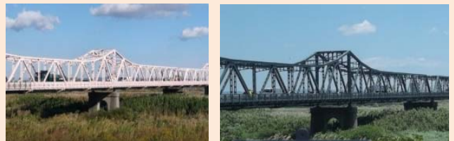
国道150号<掛塚橋>
