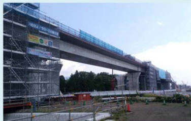
新東名高速道路＜仁杉高架橋＞
