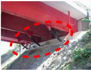
国道135号白田橋
