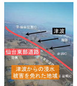
(例) 仙台東部道路の状況
