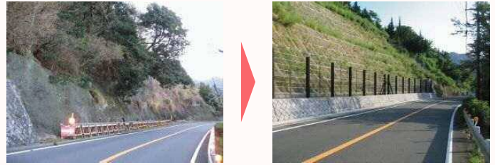
国道136号（松崎町岩地）
