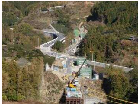
建設が進む中部横断自動車道 (静岡市清水区吉原)
