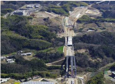
建設が進む伊豆縦貫自動車道 (三島市塚原)
