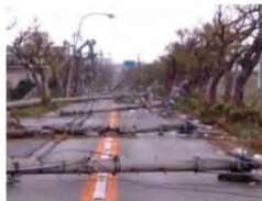
<電柱の倒壊による道路閉塞>
