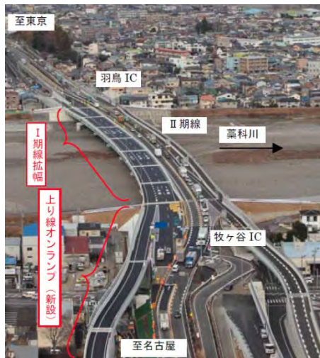
薬科川橋の工事状況 （平成27年3月1日 4車線開通）
