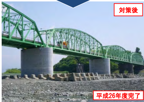
橋脚コンクリート 巻き立て補強
