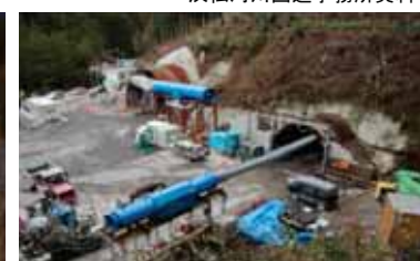
佐久間第1トンネル工事状況 (浜松市天竜区)
