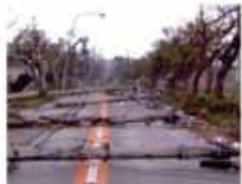
<電柱の倒壊による道路閉塞>
