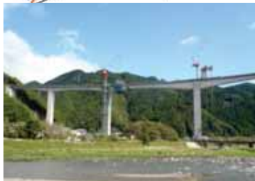
興津川橋工事状況 (静岡市清水区)
