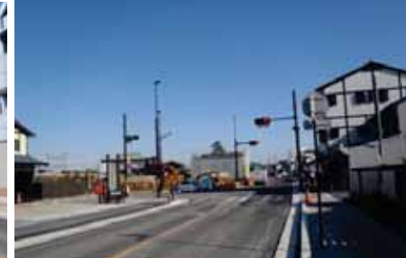
工事状況（平成26年度完成予定）
