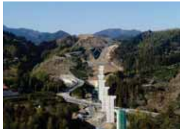
吉原VA工事状況 (静岡市清水区)
