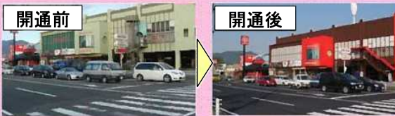
新静岡ICの開通により静岡市街地にある静岡IC周辺道路の交通環境が改善(静岡市)
