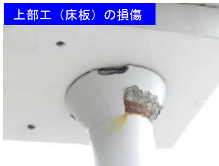
下部工（橋脚）の損傷
