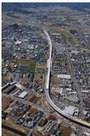
国道136号 函南～三島バイパス （函南町間宮～函南町大土肥）
