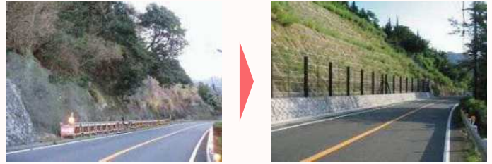
国道136号（松崎町岩地）
