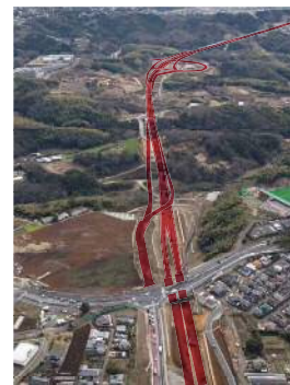
建設が進む伊豆縦貫自動車道 (東駿河湾環状道路 三島市塚原)
