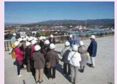
国道136号における工事現場見学会
