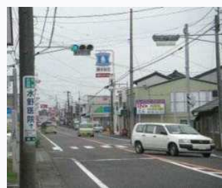
バイパス整備後の現道 （島田市阪本）
