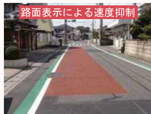
路面表示による速度抑制 県道田子浦港大野線 （富士市今井）
