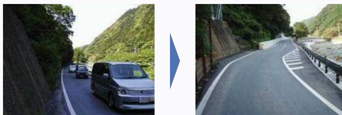
県道伊東西伊豆線（西伊豆町一色）
