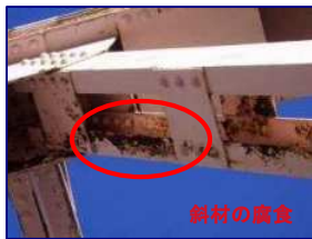
国道150号 掛塚橋
