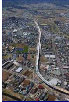
国道136号 函南～三島バイパス (函南町間宮～三島市大場)
