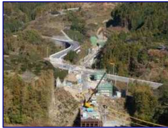
建設が進む中部横断自動車道 (静岡市清水区吉原)
