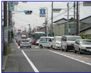
バイパス整備前の現道
