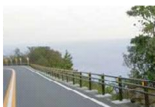
国道135号(下田市白浜)
