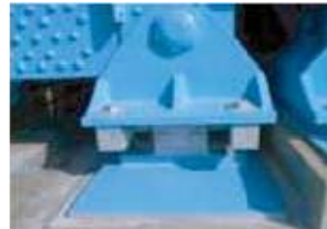
橋梁の部材の予防保全
