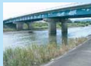
地震に備えた橋脚の補強
