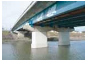
国道150号 朝比奈川橋 (焼津市中里)
