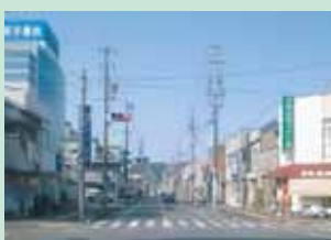
電線類の無電柱化
