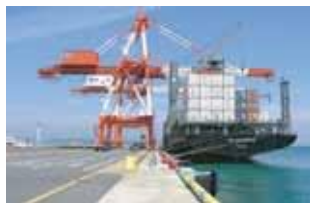
重要港湾 御前崎港
