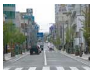
無電柱化した 県道三島富士線 （三島市本町）
