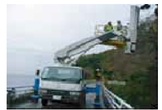
点検車両による橋梁点検状況
