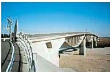
浜松御前崎自転車道（潮整橋）
