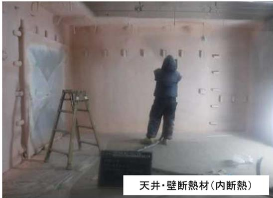
天井・壁断熱材(内断熱)
