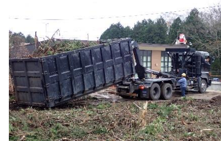
トラックへ積込・運搬
