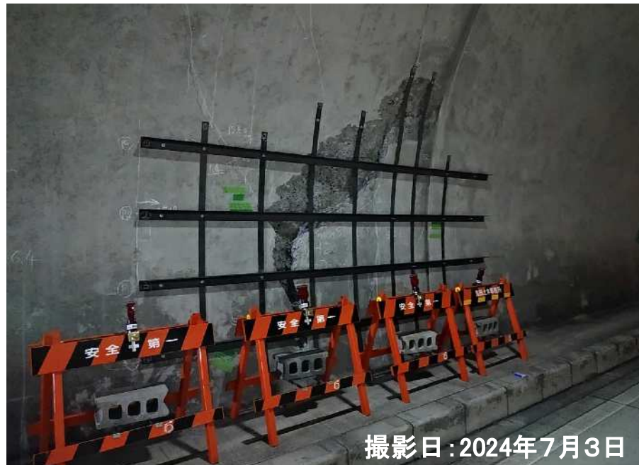
■トンネル内のひび割れ状況
