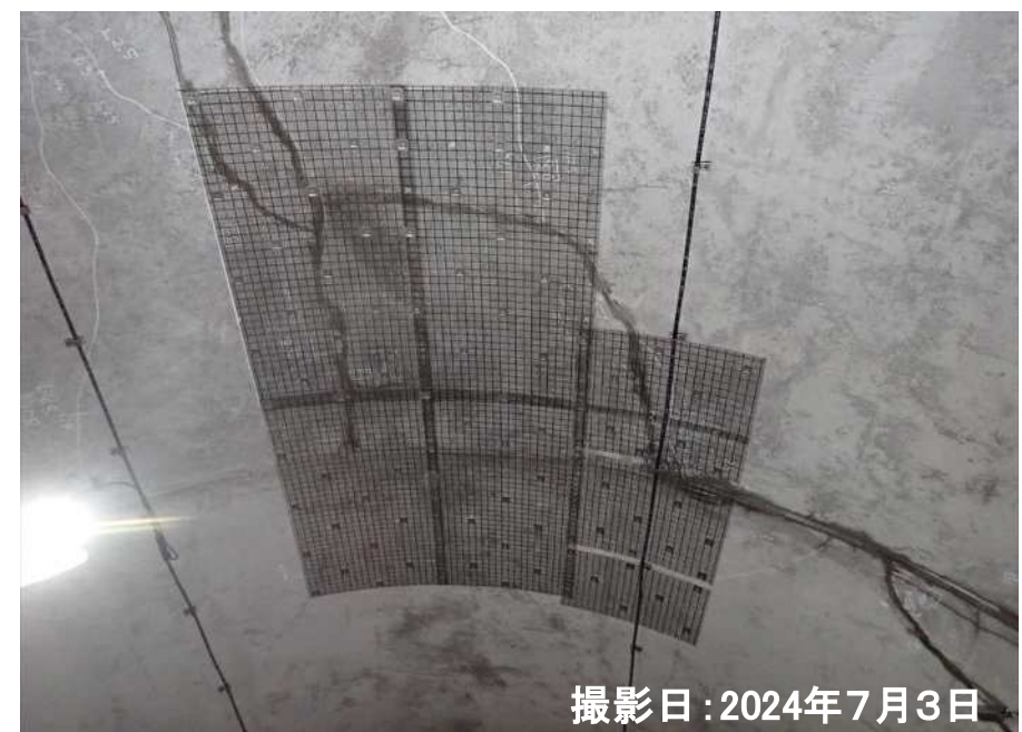
■トンネル内のひび割れ状況
