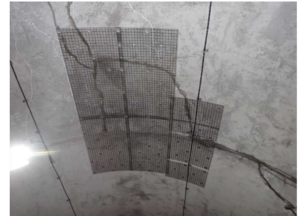
6月11日に天端のひび割れ(S-24)に対してメッシュシートを施工
