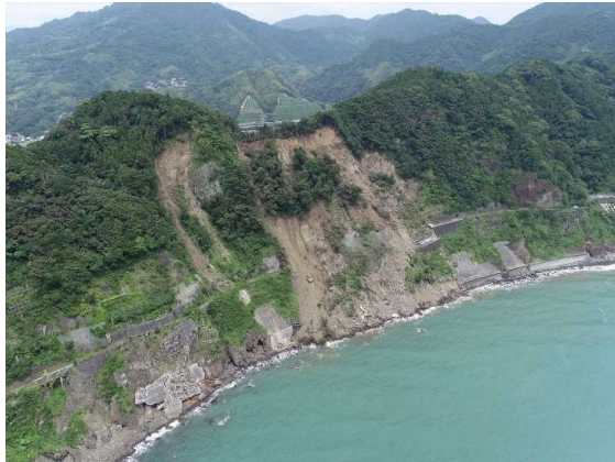
斜面崩壊全景（R6.7.3撮影）
