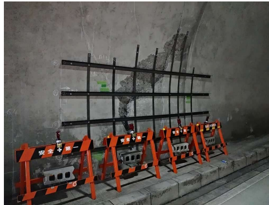
4月26日 S32当て板工の状況
