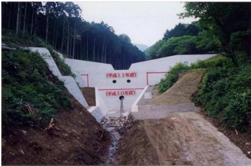
堰堤の3つの穴は「水抜き穴」と呼ばれるもので、上流側から流れる水を流すものです。一番下の穴が、完成時点の堰堤上流側の地盤の高さ(図面の青線)になっており、写真のとおり、水が流れているのが分かります。
