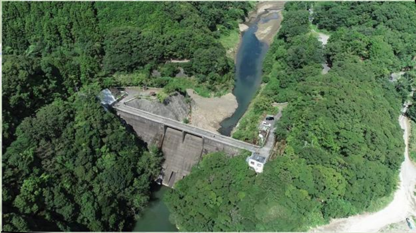
原野谷川農地防災ダム
