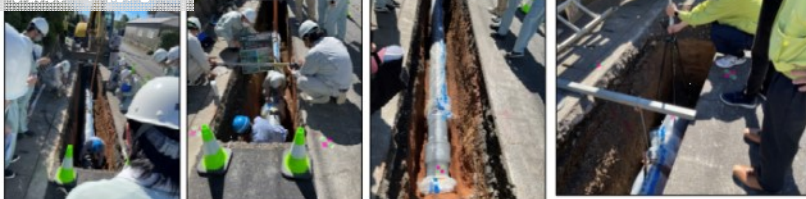
①掘削・管設置 ②管位置検査 ③位置決定後、管被覆を一時的にめくる ④測定
