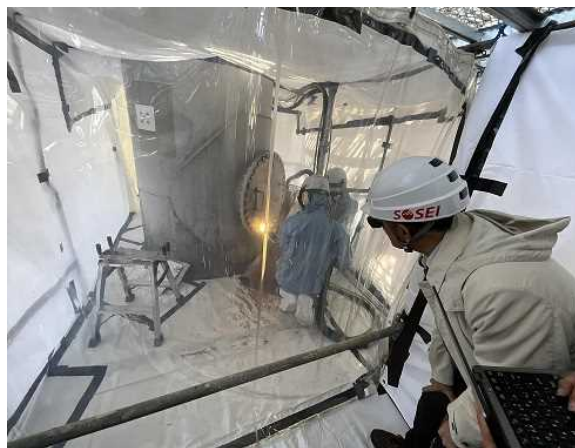
【デモ施工の様子】
