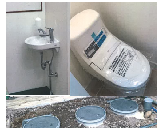
▲トイレ設備の設置
