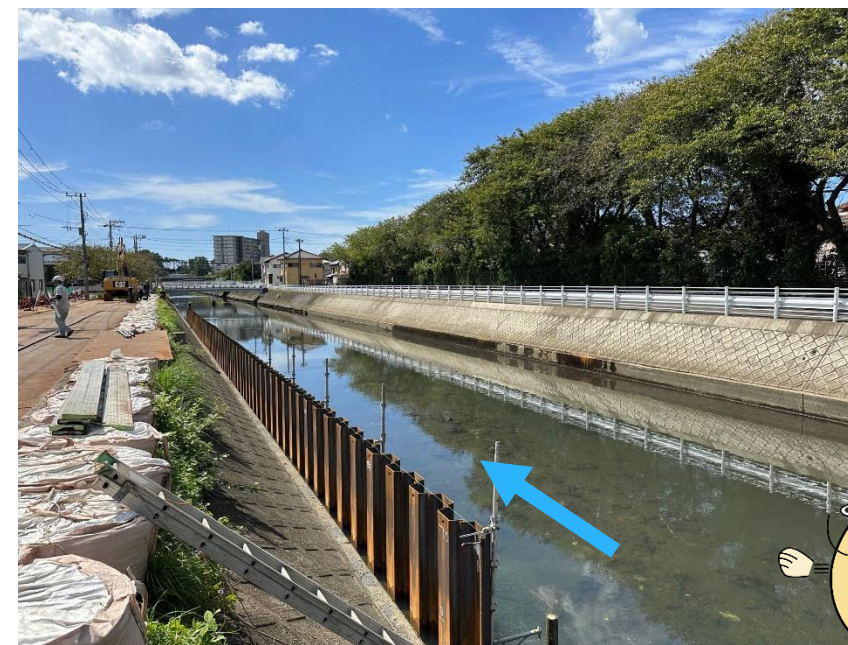
矢板護岸整備状況
