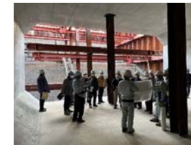
トンネル部の内部
