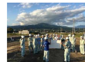
国1バイパス北側の盛土工事
