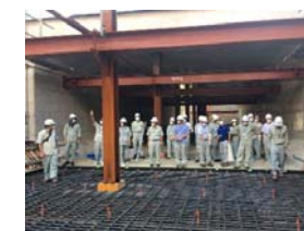
トンネル部の鉄筋組立
