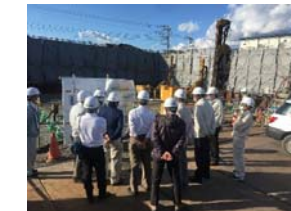
地盤を固める工事
