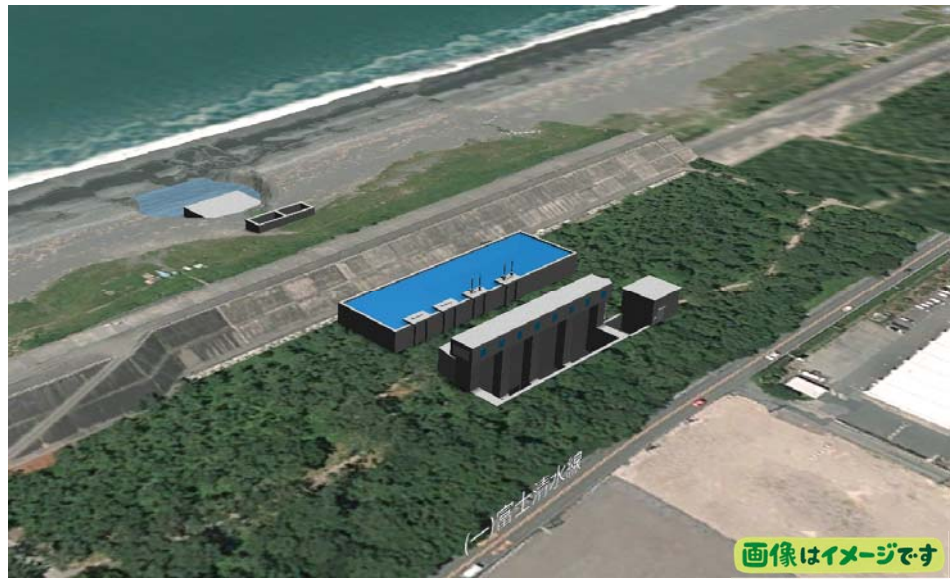
沼川新放水路防潮ゲート部
