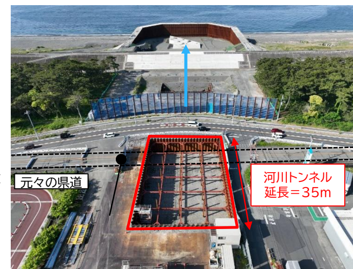
県道交差部の着手前状況（令和6年4月）
