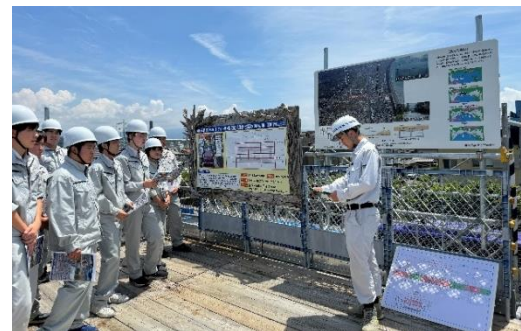
現場監督から工事説明
