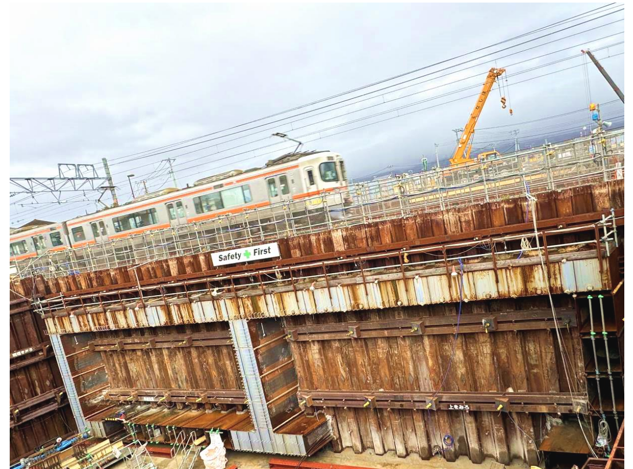
令和6年2月19日撮影（JR交差部工事状況）
