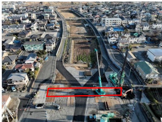
工事箇所の航空写真
