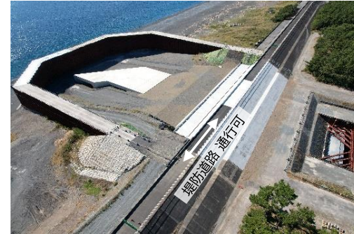
放流口の完成状況（令和5年11月）
