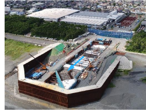
工事中の状況（令和4年7月）
