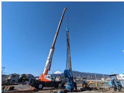
仮締切工の施工写真
