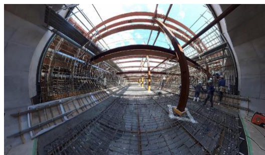
底版部施工状況（360度カメラで撮影）
