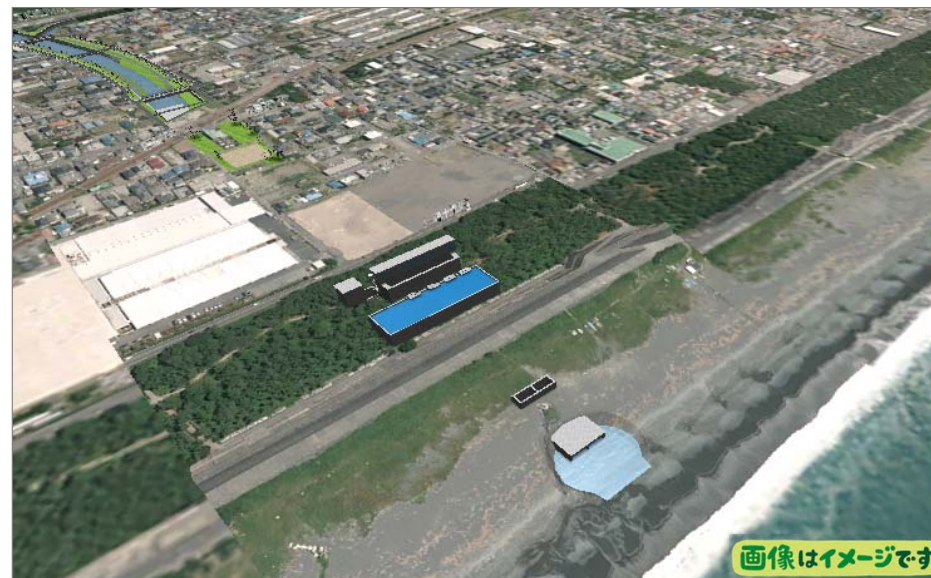
沼川新放水路吐口部
