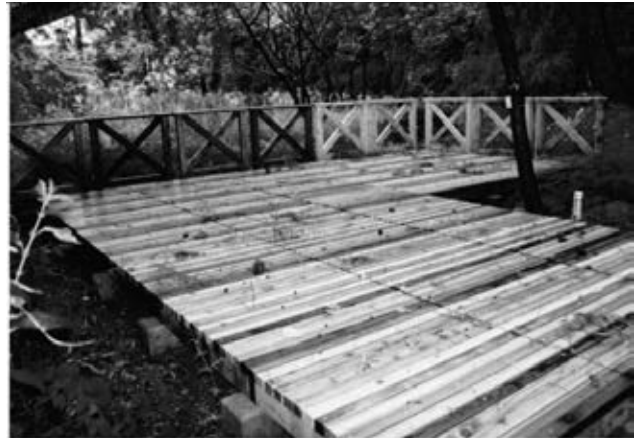
図1 デッキボードの設置状況
