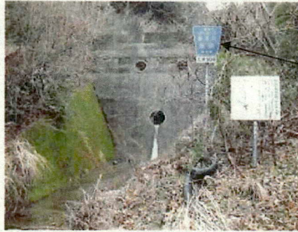
収去地点 (砂防ダム出口)
