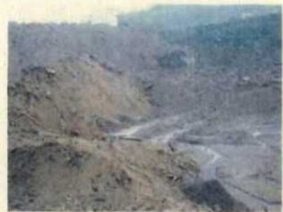
③ 盛土状況
