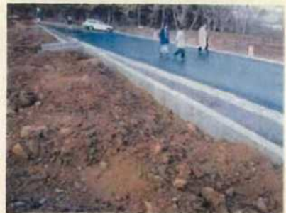
⑥ 擁壁背面状況
