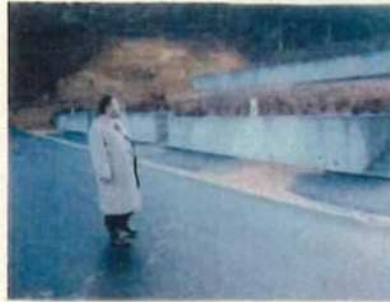
② 擁壁状況
