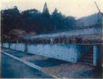
④ 擁壁状況
