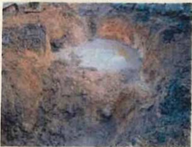
⑭ 仮基礎状況
