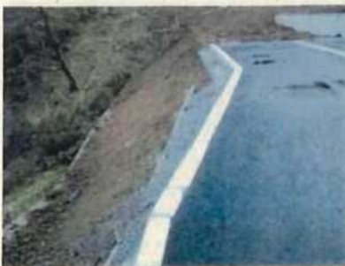
擁壁上部盛土状況
