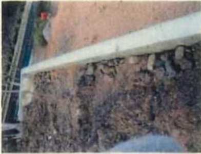
① 擁壁背面状況
