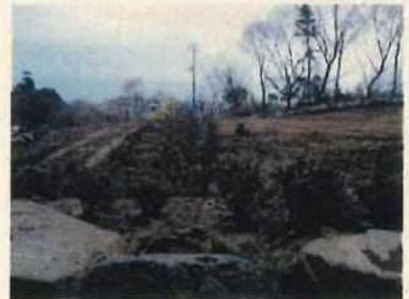
⑨ 仮防災施設
