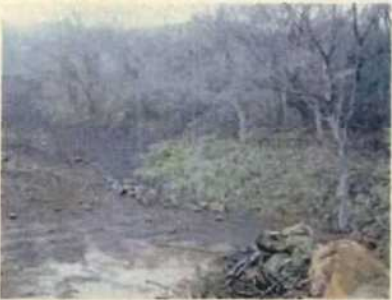
④ 掘削状況
