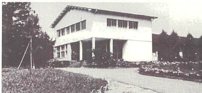
旧林業試験場本館（昭和 45 年頃）
