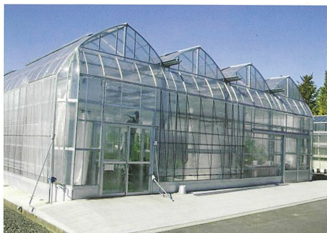
研究所内に建設したメロン低コストモデル温室 (面積 205m 2 東西 16.0m×南北 12.8m、軒高 4.0m) モデル温室は現地に設置する場合 1 棟 30a 程度を想定している。
