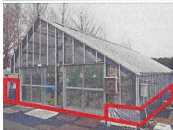
温室基礎コンクリート部分 を断熱強化した温室 ※赤線枠内が断熱した部分
