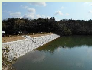
ため池の耐震工事
