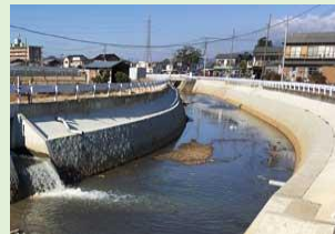
排水路整備(柿沢川南部地区)
