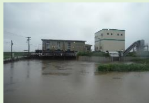
排水機場(毘沙門2期地区)
