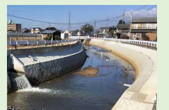
排水路整備（柿沢川南部地区）
