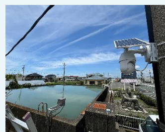
遠隔監視システム
