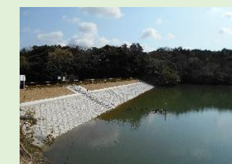
ため池の耐震工事
