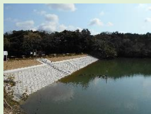
ため池の耐震工事
