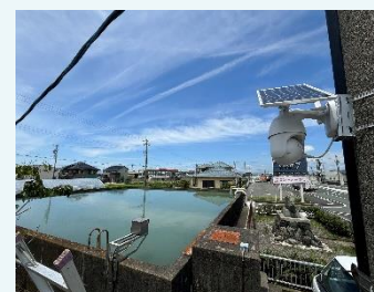
遠隔監視システム
