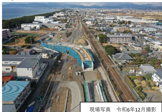
現場写真 令和6年12月撮影
