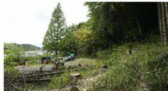
②深井戸設置作業の様子
