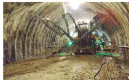
④薬液注入作業の様子
