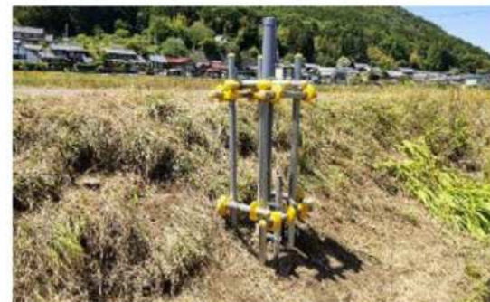
③観測井4の設置状況
