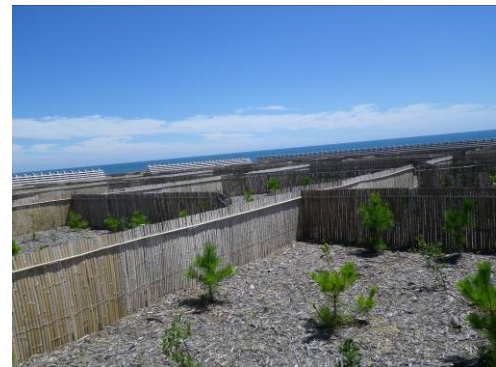
海岸防潮堤への植栽
