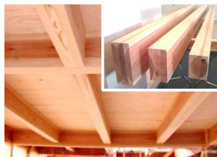
スギ積層接着合わせ梁及び施工状況
