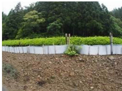
写真②トタン板による柵
