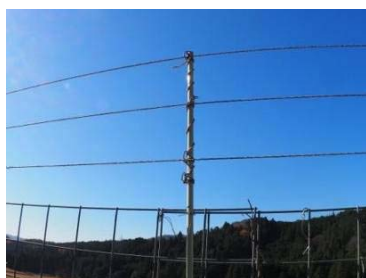
電線を巻きつけた支柱
