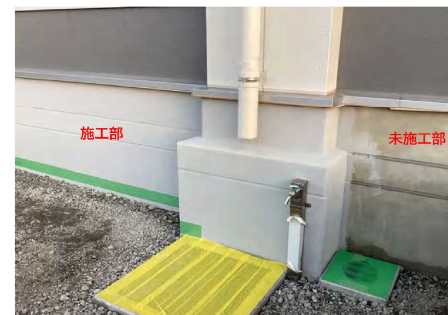
腰壁部劣化対策施工
