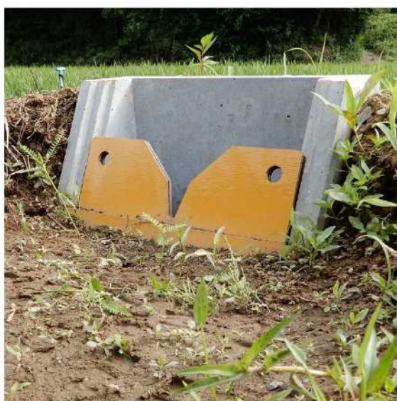
安価な木製堰板(田んぼダム用Vカット入)落水枡
