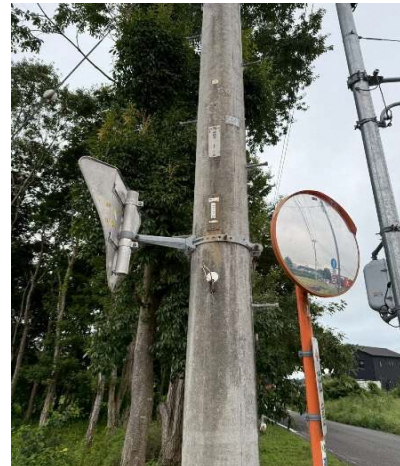
⑤電柱写真
