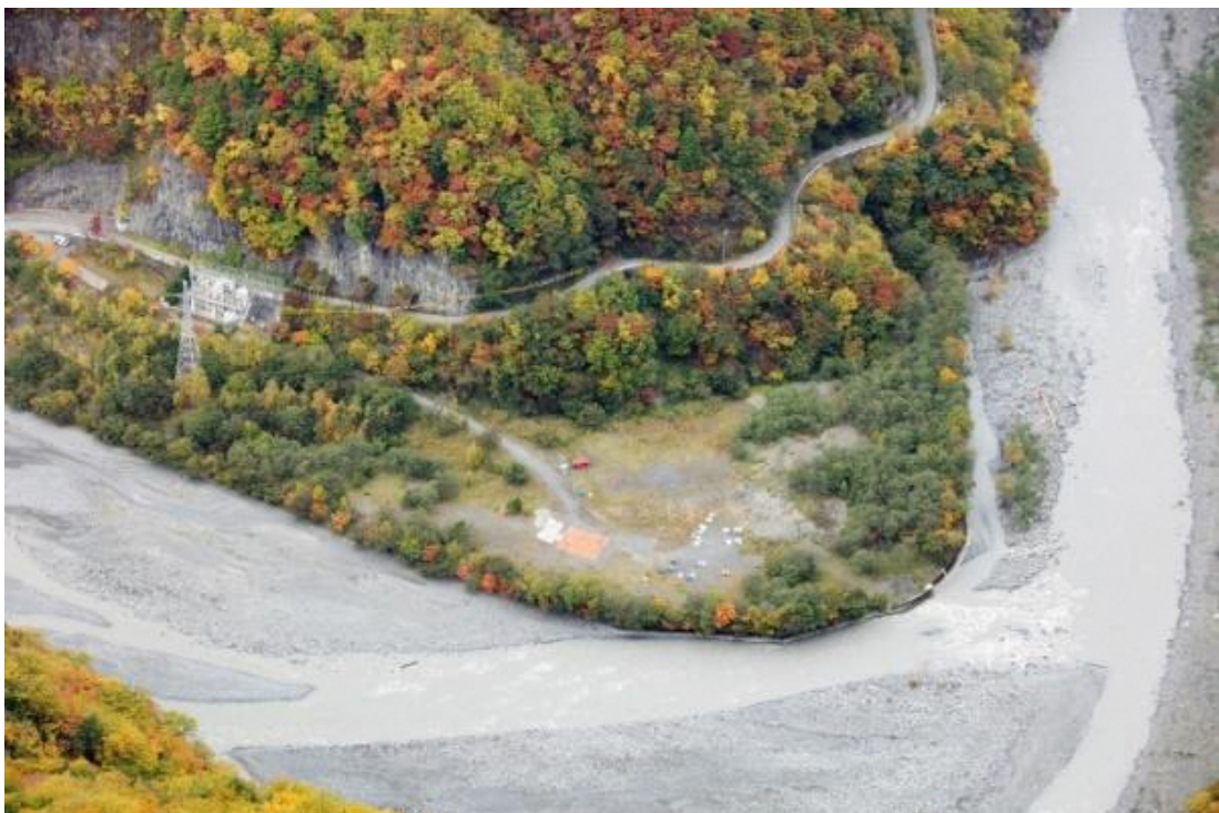
写真3 削石付近現況
