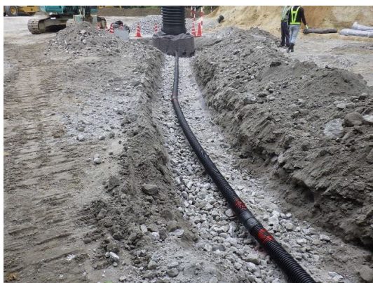
写真 1 水平排水工及び縦排水工の例
