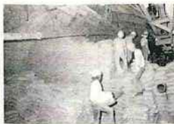
作業坑バルクヘッド搬送
