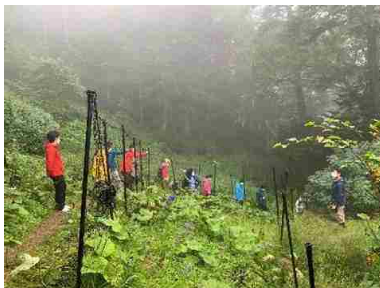
写真 8 獣害防止柵の設置例（千枚小屋付近）
