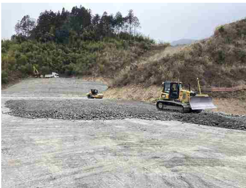
写真 4 他工区における施工状況
