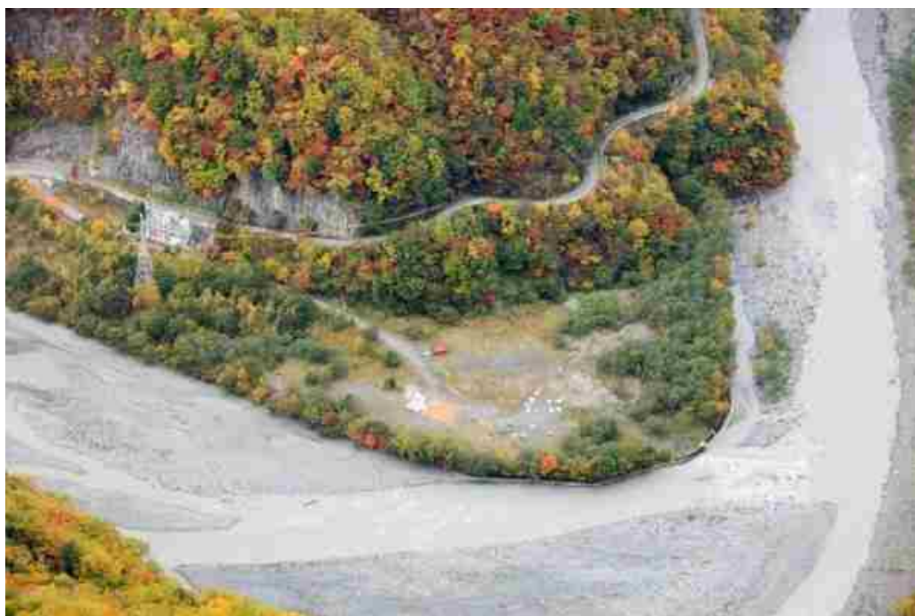
写真 １０ 剃石発生土置き場現地状況
