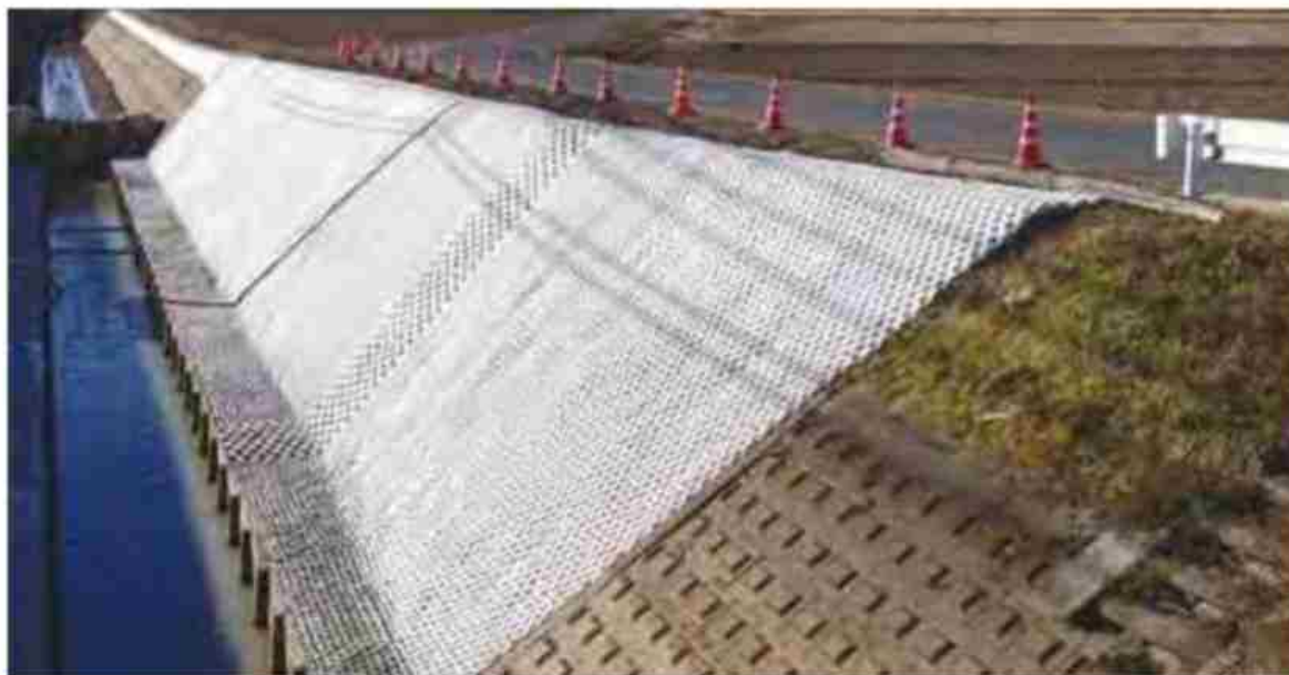
図 144 ファブリフォーム施工イメージ
