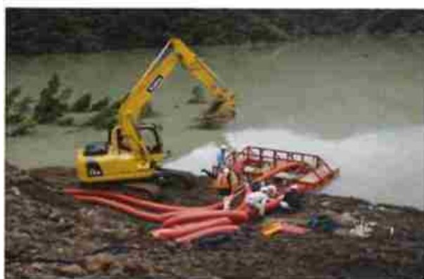
排水ポンプの設置
