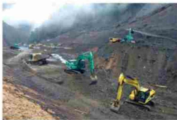
重機を用いた崩土の撤去
