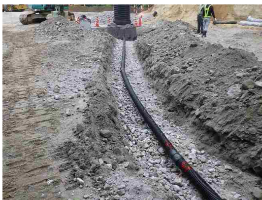
写真 3 水平排水工及び縦排水工の例
