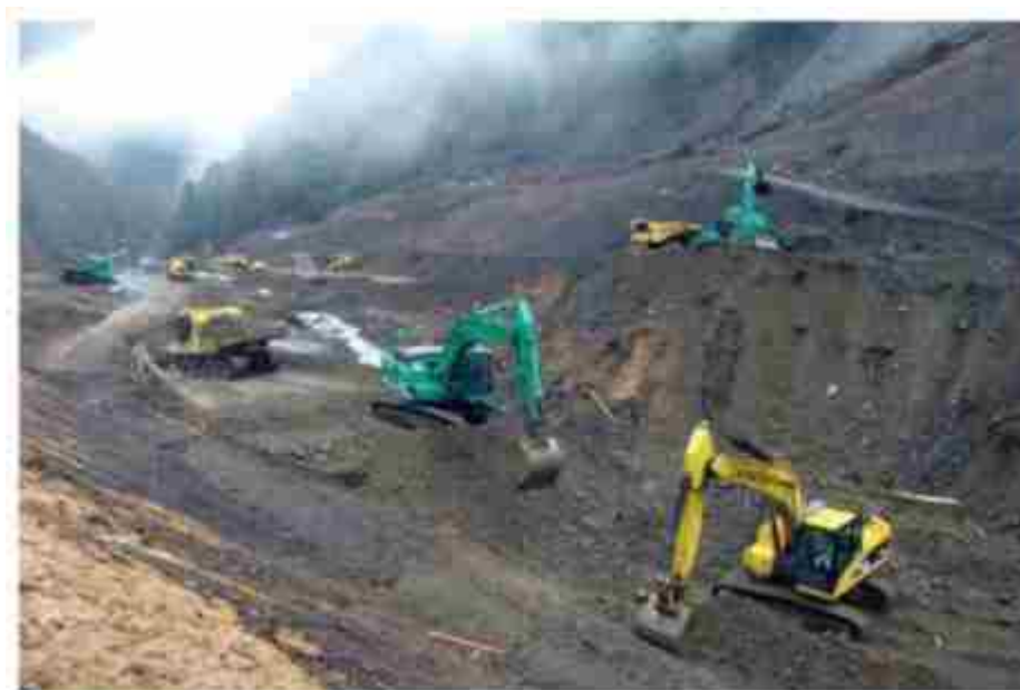
図 8 7 崩土撤去等の対応イメージ（再掲）
