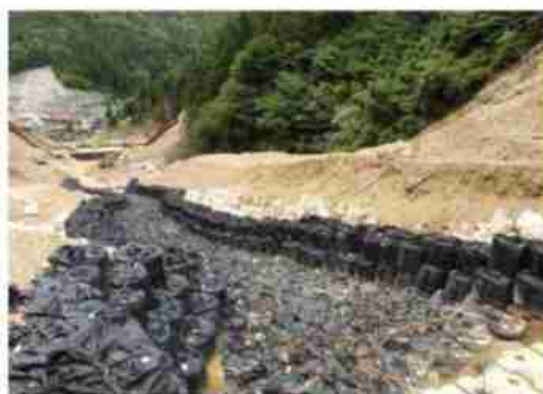
仮設排水路の整備
