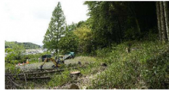
②深井戸設置作業の様子
