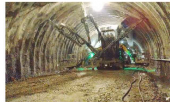
④薬液注入作業の様子
