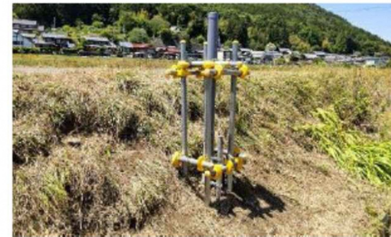
③観測井4の設置状況
